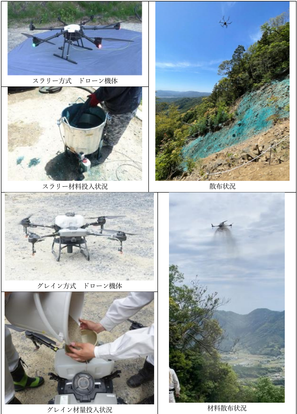
写 3 岩国での施工状況
