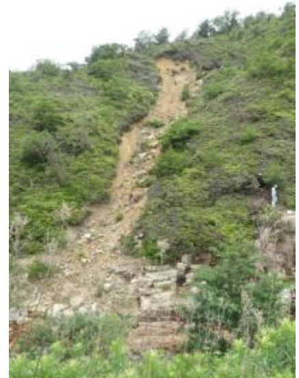
写9 施工前の斜面
