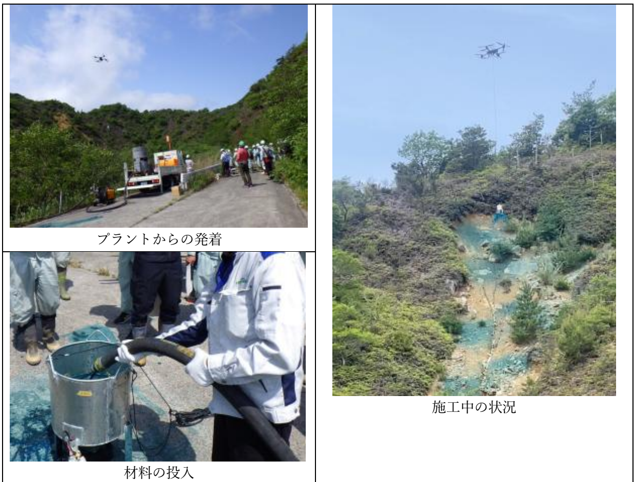
写10 防府での施工状況
