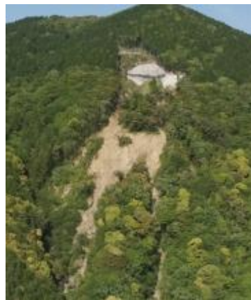
写 2 施工前遠景
