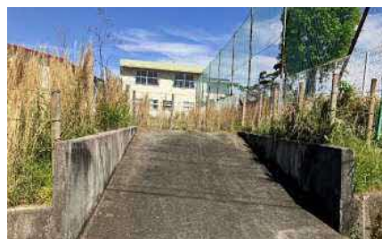
【スロープ(東側)】
