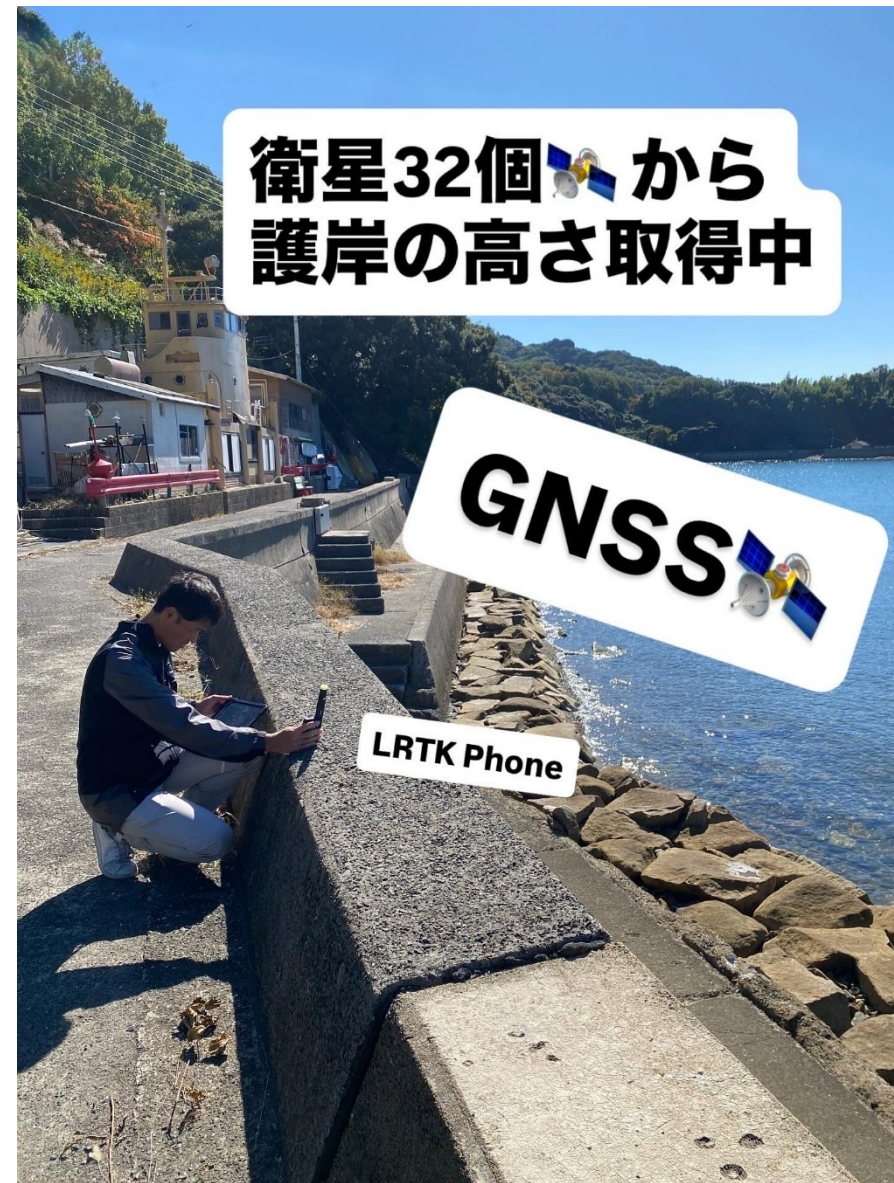
図2 LRTK測位の様子
