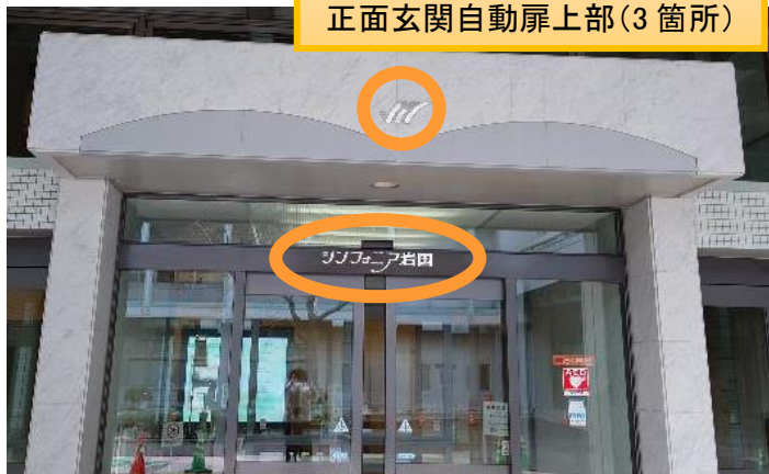
正面玄関自動扉上部(3箇所)
