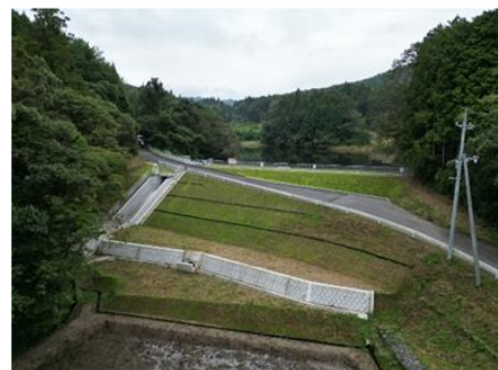
改修したため池
