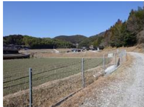
鳥獣侵入防止柵の設置
