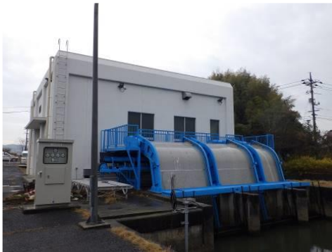
排水機場の機能保全対策
