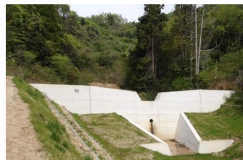
治山ダムの整備
