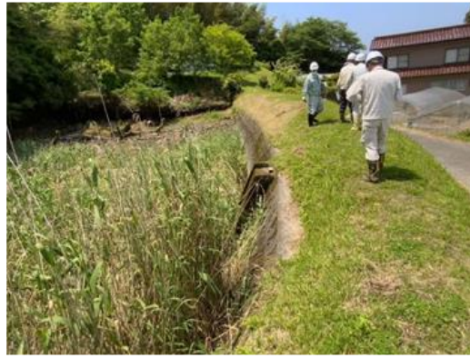
ため池点検パトロールの様子
