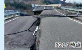
写真④ 国道249号鳥川橋
