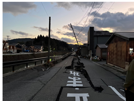
道路のひび割れ（輪島市）
