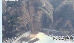
写真③ 国道249号法面崩落
