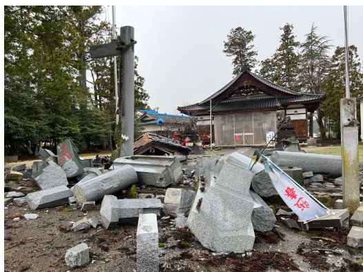
神社の鳥居の倒壊（輪島市）
