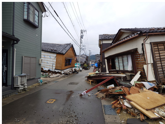
建物の倒壊（輪島市）
