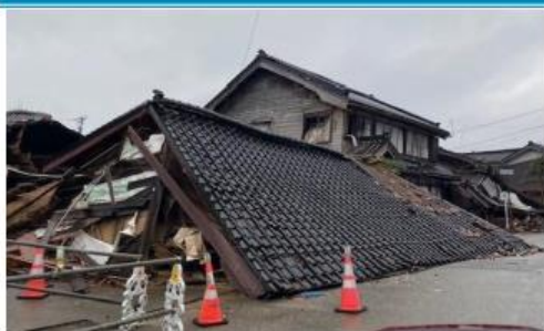
家屋倒壊 (珠洲市三崎町地内)
