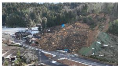
山腹崩壊 (珠洲市正院町地内)
