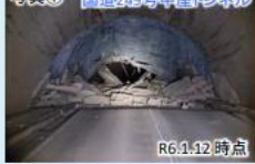
写真① 国道249号中屋トンネル
