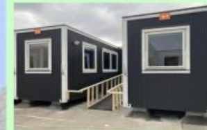
ムービングハウス（輪島市完成例）
