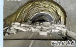
写真⑤ 国道249号大谷トンネル
