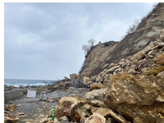
崖崩れ（輪島市）
