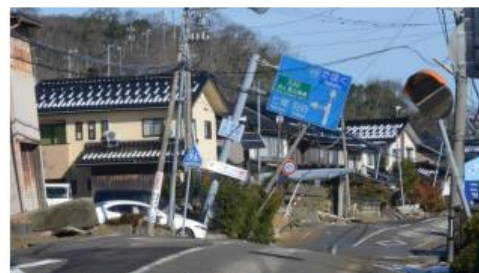
液状化 (内灘町西荒屋地内)
