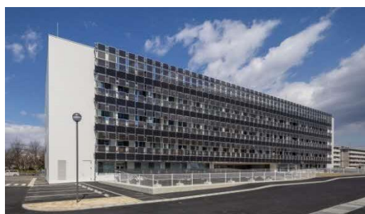
図 3.5.2 建物と一体的な太陽光パネル (出典：愛知県 HP)
