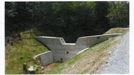
【治山ダムの整備】
