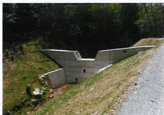
【治山ダムの整備】
