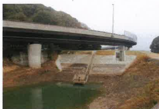
【ため池の改修】
