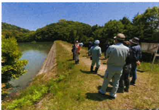
【ため池点検パトロール】
