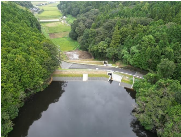
完成した納所ため池を上流から撮影
