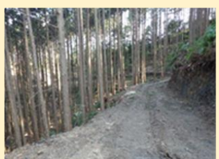
森林作業道の整備
