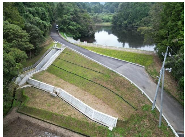
完成した納所ため池を下流から撮影
