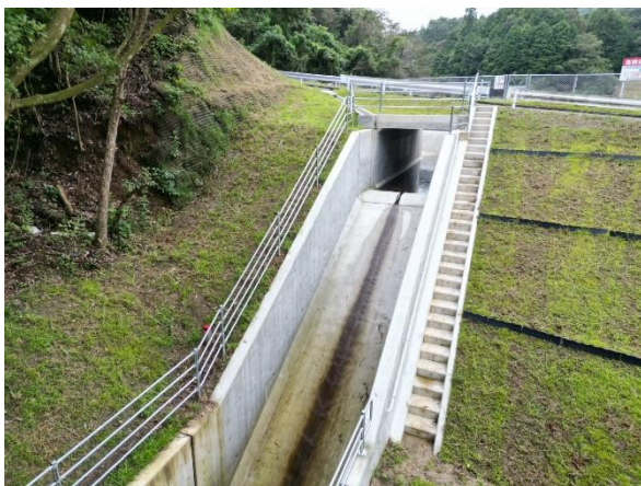
完成した納所ため池の洪水吐
