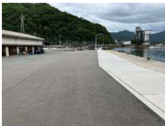
工事実施後（萩漁港）
