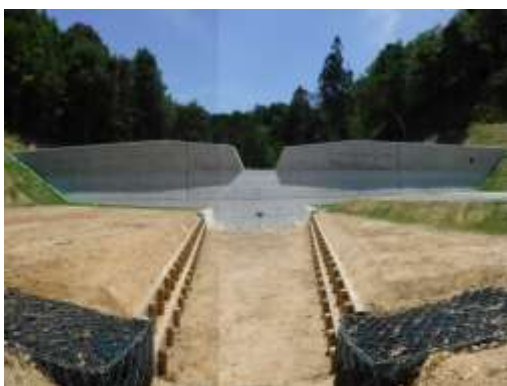
治山ダムの整備 (山口市：大迫地区)
