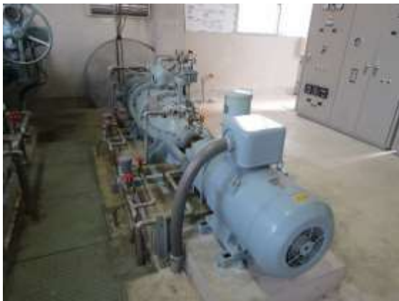
排水機場の改修 (長門市：三隅地区)
