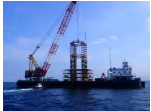
鋼製魚礁設置状況（萩市）
