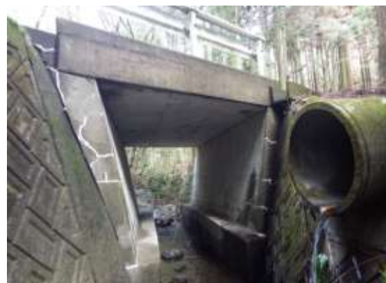
林道橋の補修 (岩国市：林道師木野線)
