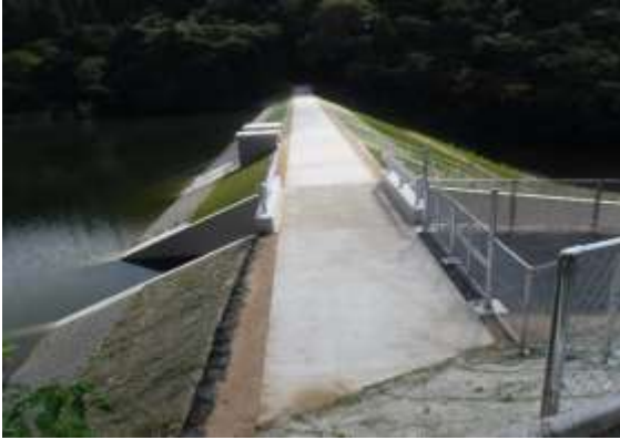
ため池の改修 (防府市：上洗川ため池)
