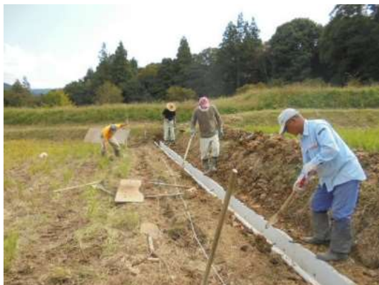
水路の更新作業 (多面的機能支払：長門市)
