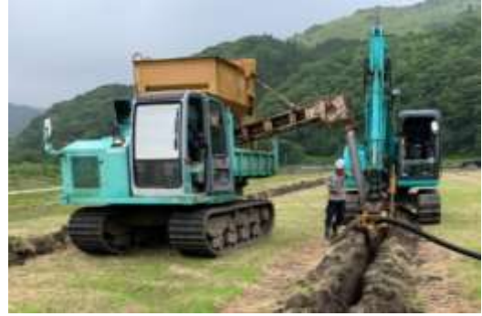
フォアス施工による水田高機能化 (山口市：島地下地区)
