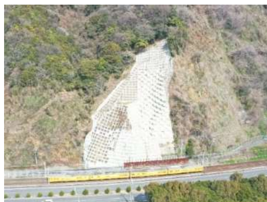
山腹工による山地災害の復旧 (光市：懸山地区)
