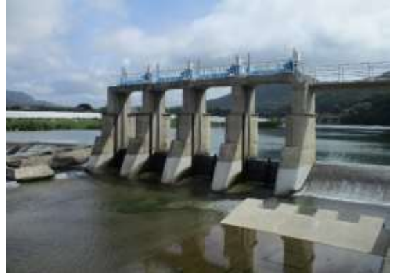
頭首工の改修 (防府市：防府総合堰)
