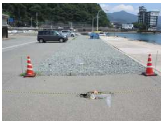
工事着手前（萩漁港）
