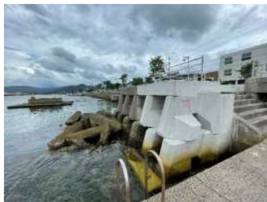
工事実施後（仙崎漁港海岸）
