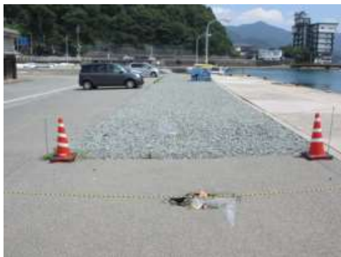
工事着手前（萩漁港）
