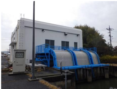
排水機場の機能保全対策
