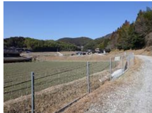
鳥獣侵入防止柵の設置
