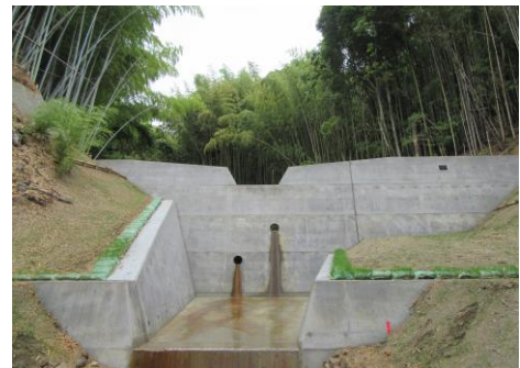
治山ダムの整備
