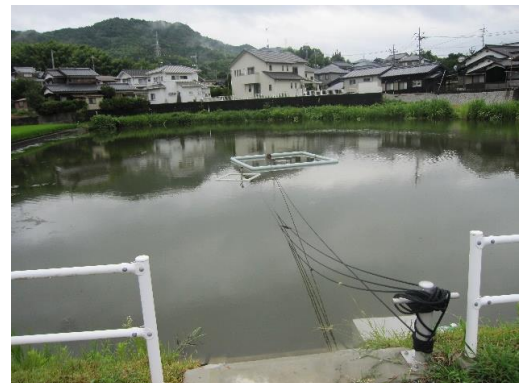
見貫池（サイホン式ため池フロート取水システム）
