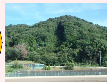
③ 施工後10年以上経過
