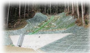
土留工・水路工・柵工・伏工・植栽工
