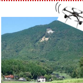
ドローンによる山腹緑化工
