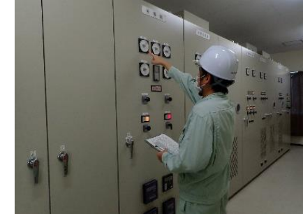
電気設備の巡視点検を行っているところ
