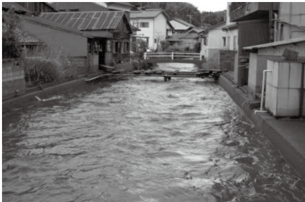
副振動により海水が逆流した片上川 (田万川・江崎地区)
