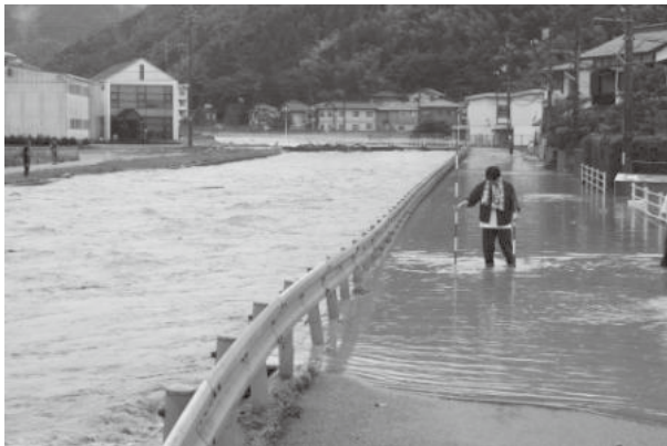
玉江川岸の河川氾濫・道路冠水
