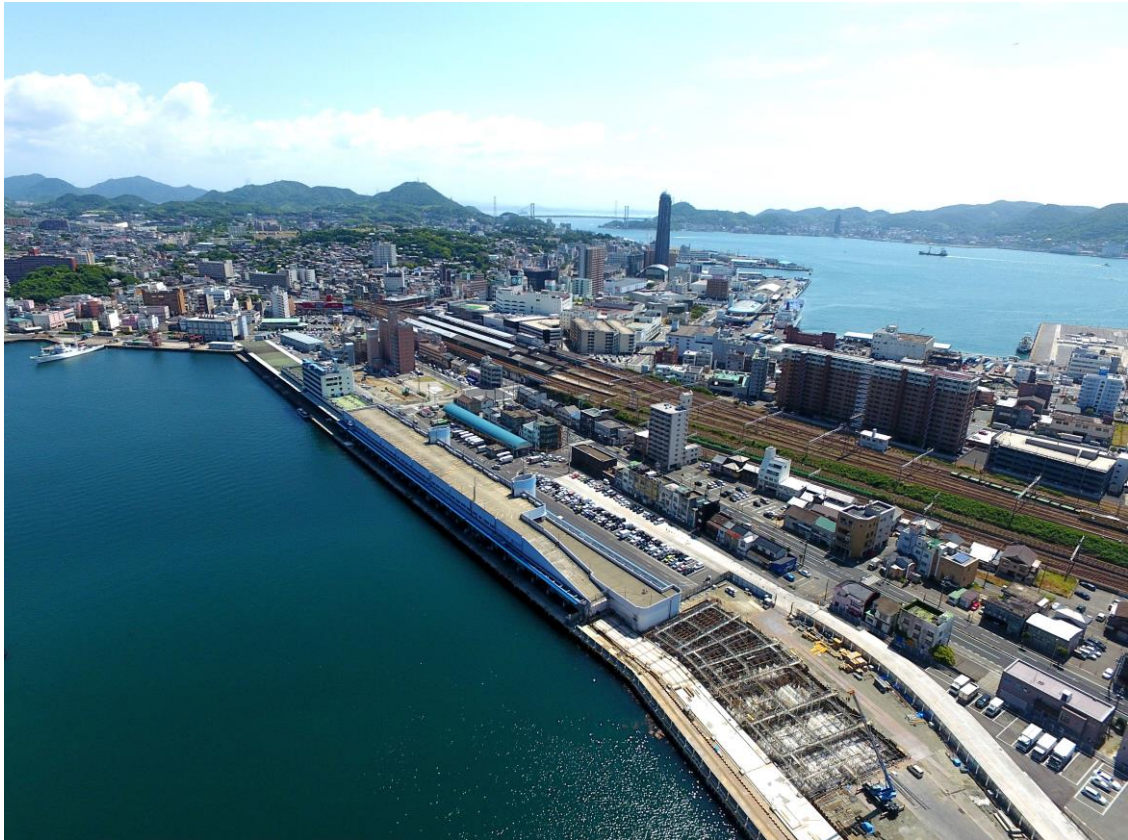
整備中の下関漁港市場（平成29年6月2日撮影）
