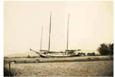
台風による嘉川付近の被害状況 (山口県文書館所蔵)
