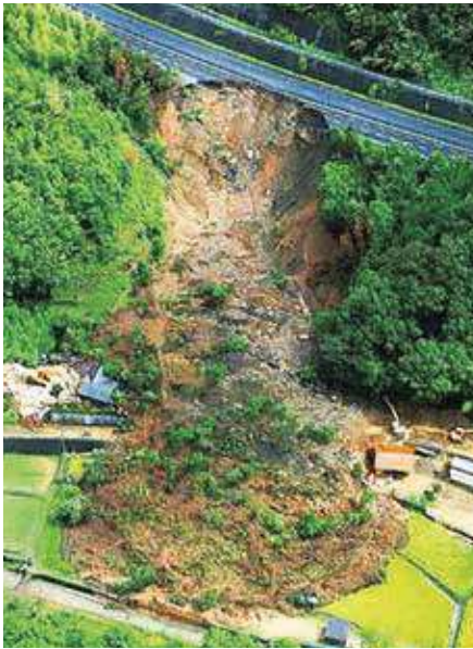
山陽自動車道の崩落(岩国市)
