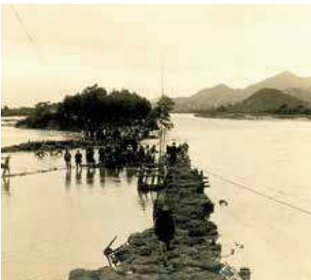
防府町字古曾原新橋下堤防決潰箇所 (山口県文書館所蔵)
