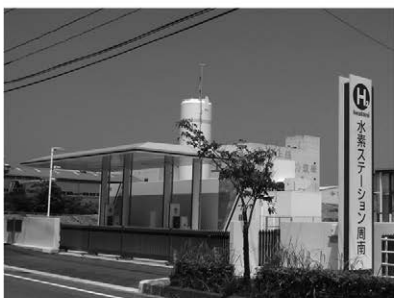
水素ステーションの整備
