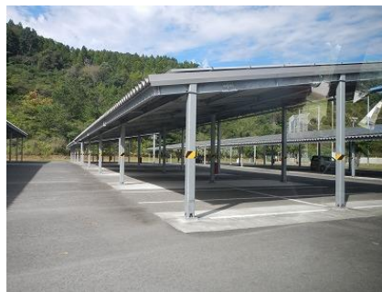
駐車場の屋根にPVを整備(第4駐車場)
