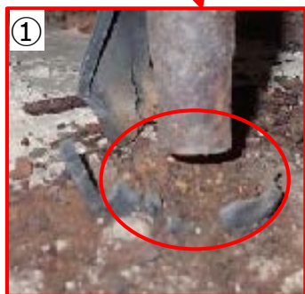
《写真①②》鉛直 P C 鋼棒の破断が目視で確認できたもの
