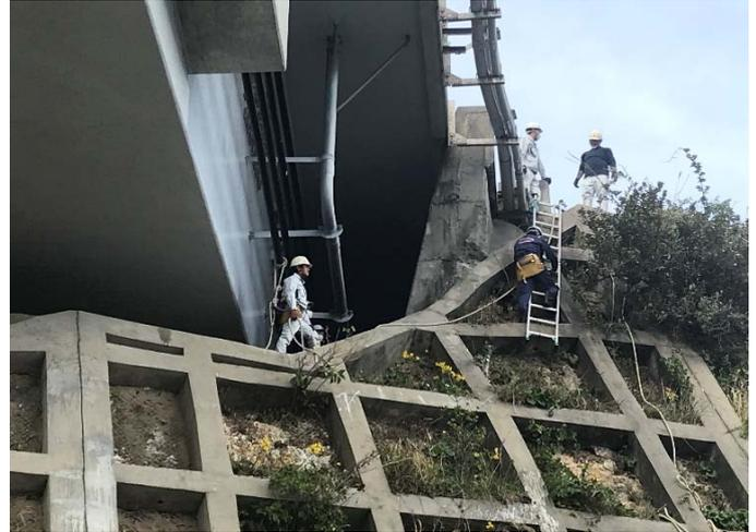
桁下部の目視による変状調査
