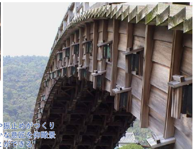
写真 2-28 3号橋脚上部付近橋上より橋脚を見下ろす
