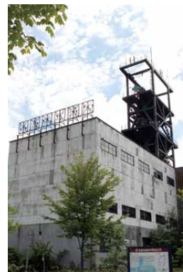
住友赤平炭鉱立坑槽(赤平市)
