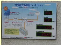
太陽光発電量の表示パネル
