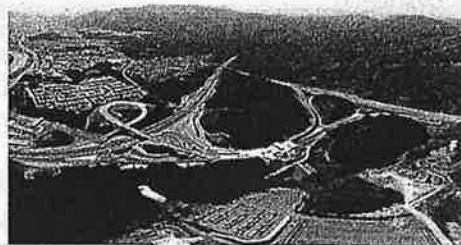
山口宇部道路小郡ジャンクション
