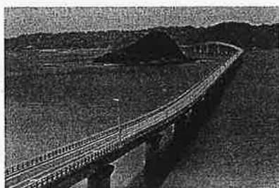
角島大橋（下関市）
