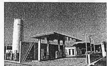
水素ステーション（周南市） 「岩谷産業株式会社」
