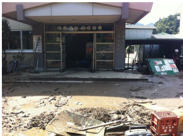
正面玄関付近
