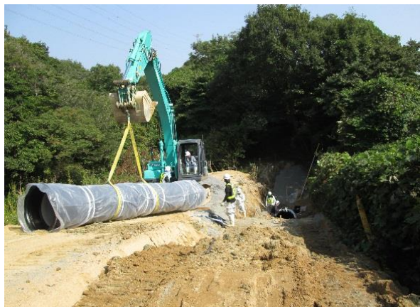
厚東川2期ルートバイパス管布設工事
