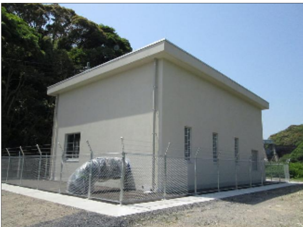
建屋、屋外配管
