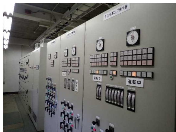
《ポンプ操作盤：更新・移設》
