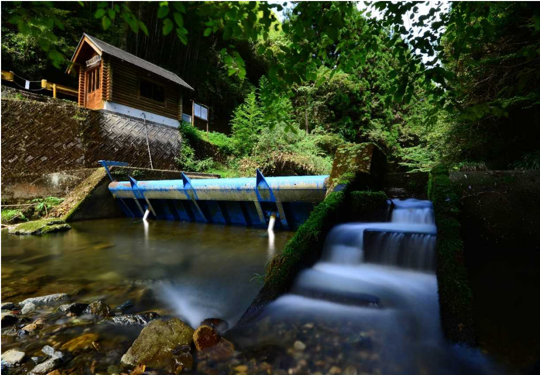
(本郷川発電所取水堰)
