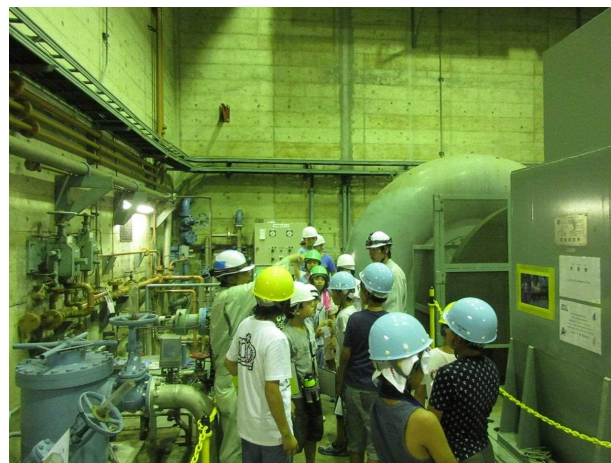
《生見川発電所》
