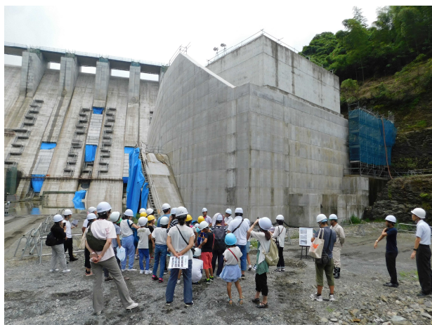
《建設中の平瀬発電所》
