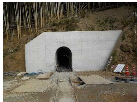
《導水トンネル（光市側）》
