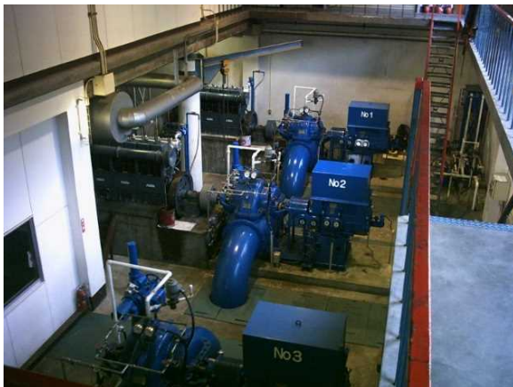
《ポンプ設備：更新》
