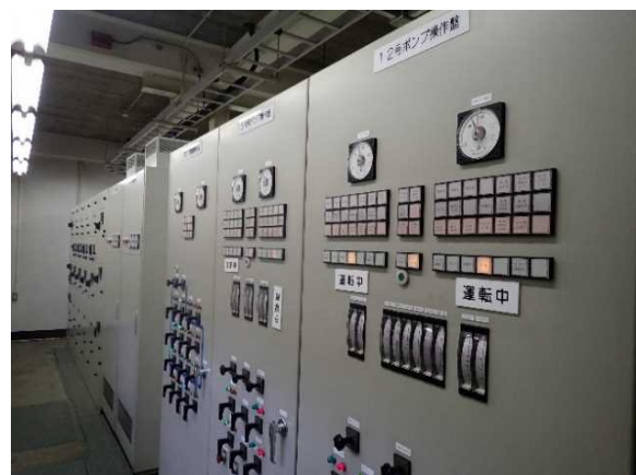
《ポンプ操作盤：更新・移設》
