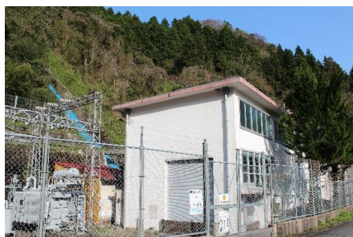
佐波川発電所
