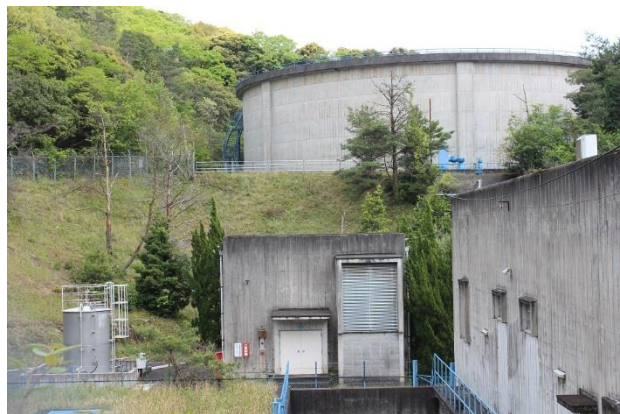
有帆ポンプ場
