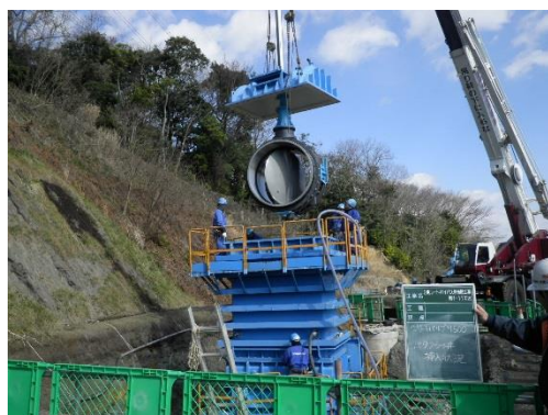
厚東川2期ルートバイパス管布設事業
