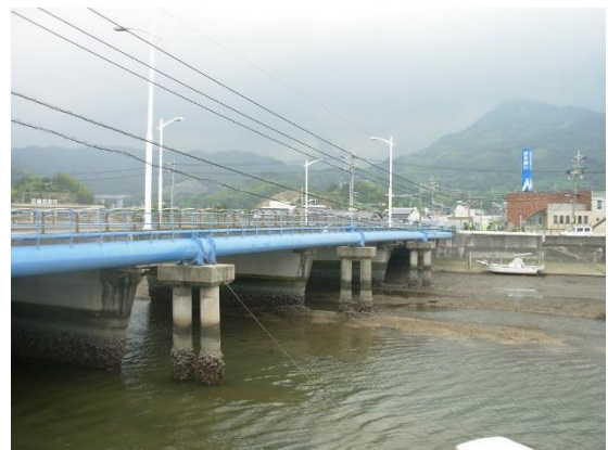
夜市川水管橋
