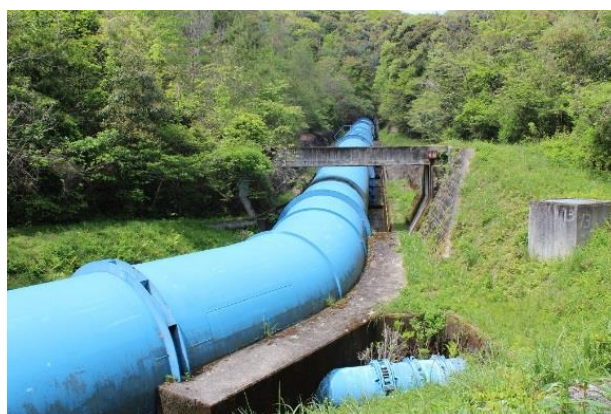
厚東川工業用水道φ4,000 連絡隧道
