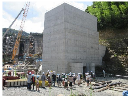
発電所見学ツアー（平瀬発電所建設現場）
