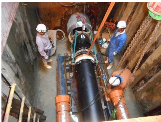
島田川工業用水道建設事業
