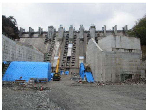
平瀬発電所建設事業
