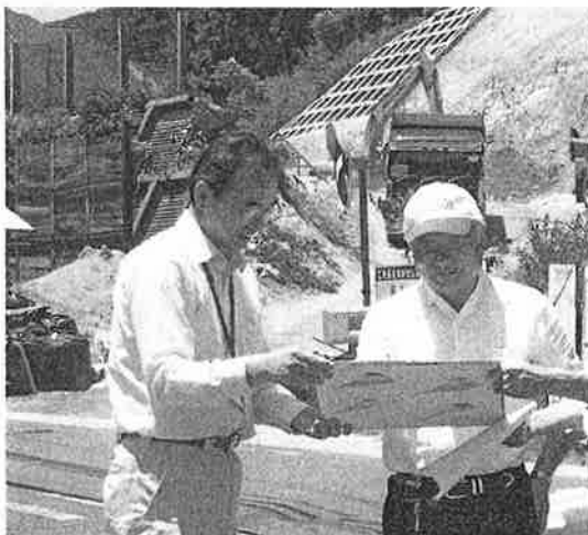
県道工事 (安下庄)
