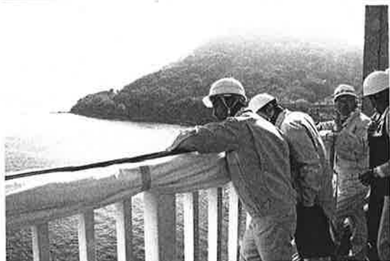
県知事と大橋損傷状況を確認
