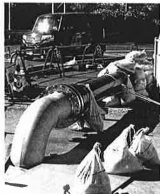
仮設管と既設管との接続
