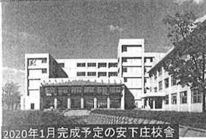
2020年1月完成予定の安下庄校舎
