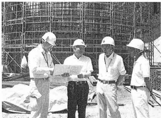
下水道処理場工事 (久賀)
