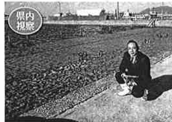
下関南風泊市場岸壁改修視察
