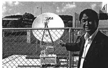
山口県産業技術センターに設置されたパラボリアンテナ わずか直径1.2mですが、膨大な情報を収集できる機能を備えています。
