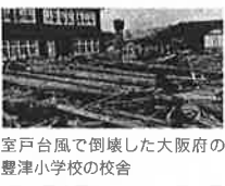
室戸台風で倒壊した大阪府の豊津小学校の校舎
