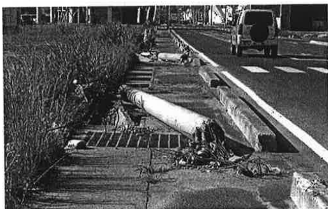
東日本大震災で倒壊した電柱
