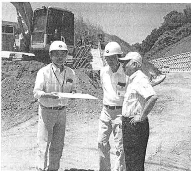
安下庄バイパス工事(古城)
