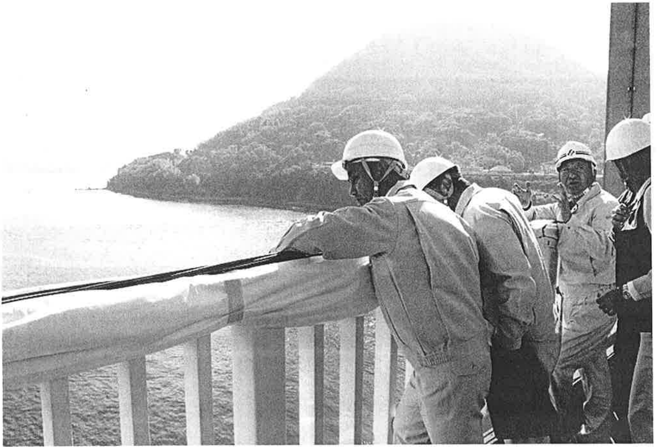
▲ 県知事と大島大橋損傷を確認
