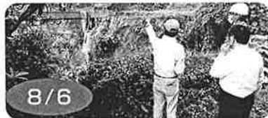
福栄別所地区歩道陥没 県土木 同行 現場第一 まずは現地視察。
