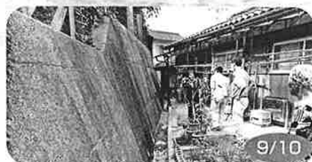
須佐地区急傾斜地崩落防止工事が来年度着工 新谷は市民の安全を最優先します。
