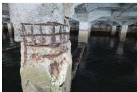
栈橋脚柱部鉄筋露出(48年経過)
