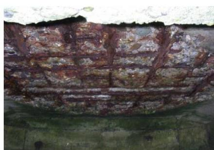
栈橋床版下面鉄筋露出(50年経過)
