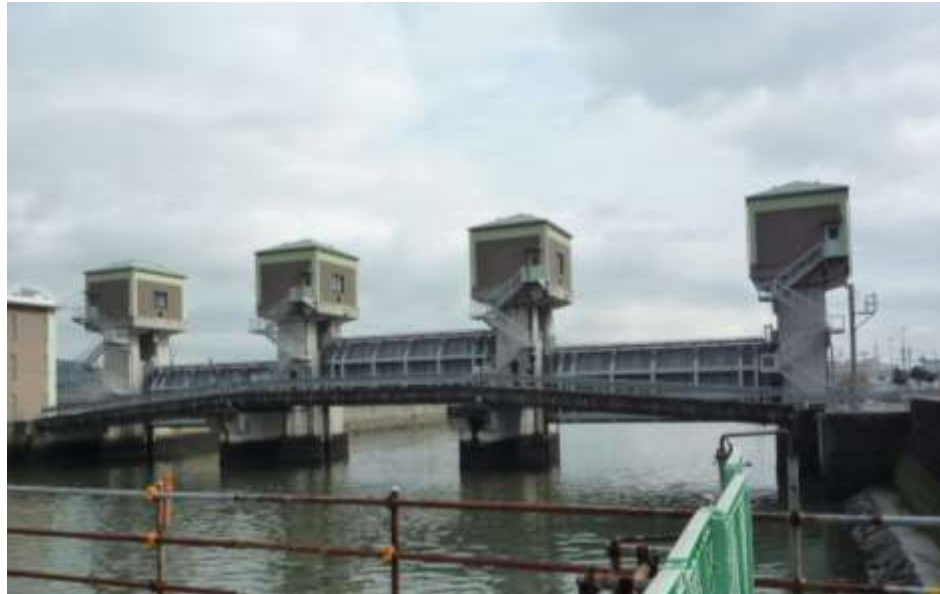
柳井川排水機場
