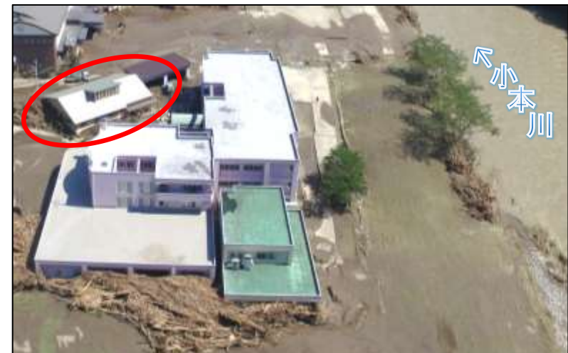
平成28年台風10号により、岩手県の要配慮者利用施設では利用者9名の全員が死亡。
