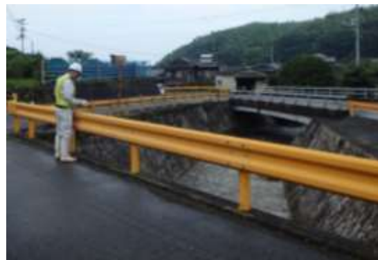
<河川巡視状況>
