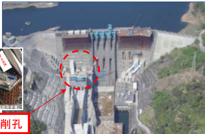
鶴田ダム再開発事業（鹿児島県薩摩郡さつま町）
