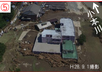
流木堆積状況
