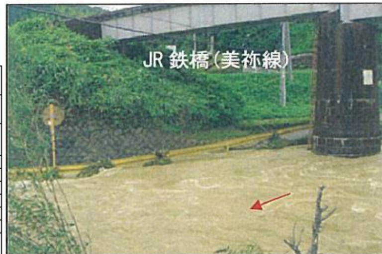
平成21年7月21日洪水：深川川(渋木八幡宮付近)
