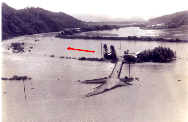
昭和39年6月25日～28日豪雨: 貞恒川合流付近
