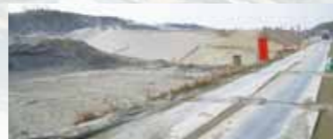
防潮堤の整備
