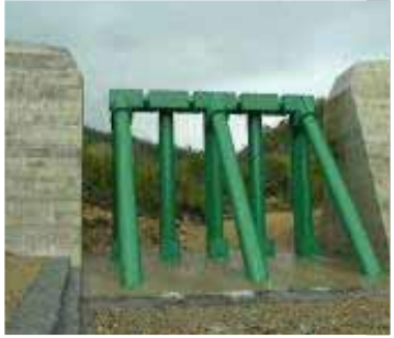
豪雨前 土砂等堆積無し
