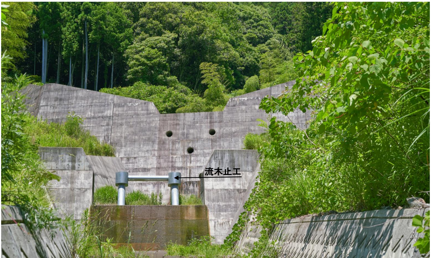
流木止工を設置した不透過型砂防堰堤 下畑東谷川 平成30年(2018年)完成 山口市
