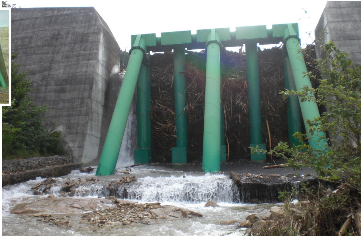
土石流を止めた透過型砂防堰堤 八幡谷溪流 平成21年(2009年)7月21日の 豪雨後 防府市
