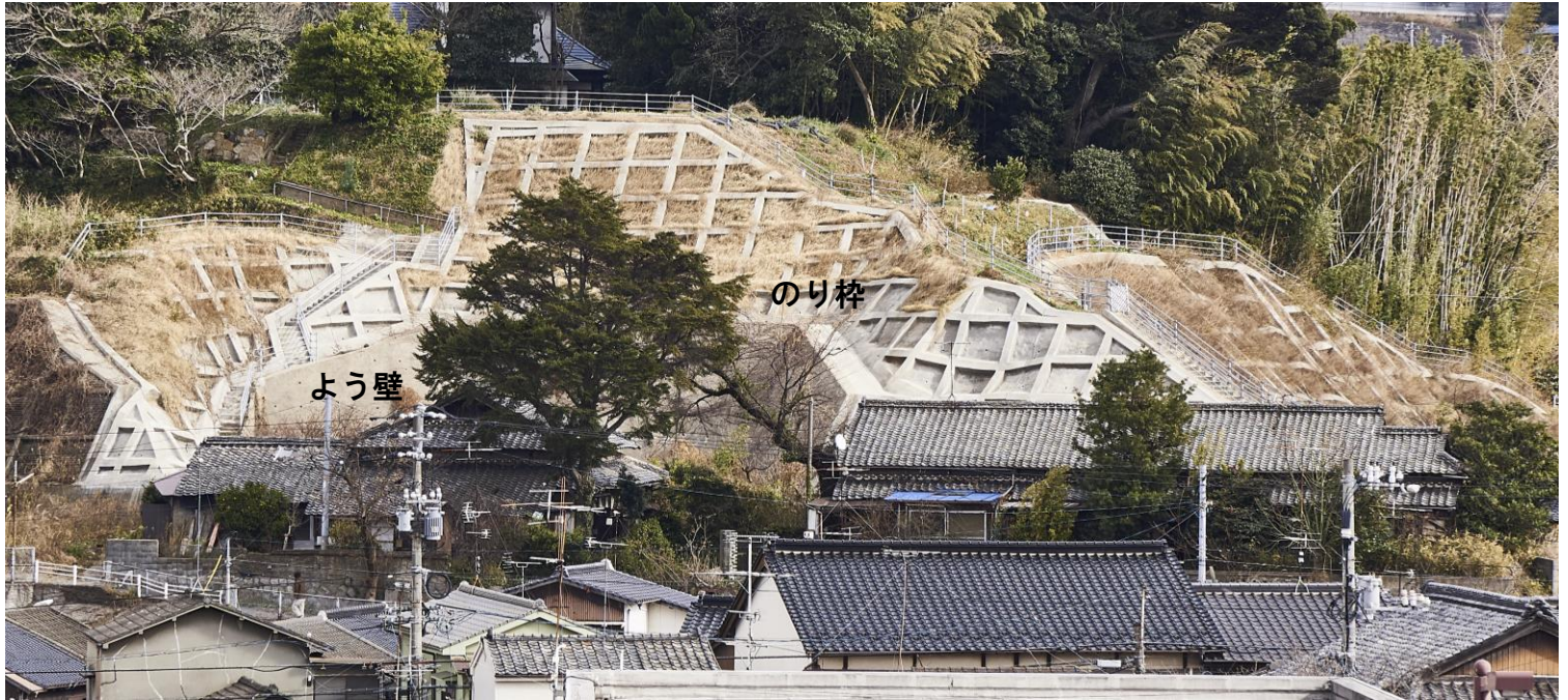
がけ崩れを防ぐためのよう壁とのり枠 下関市
