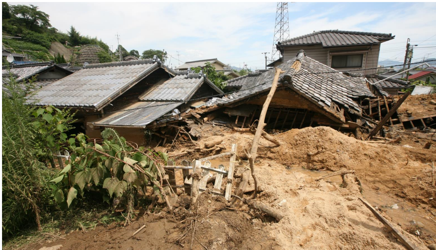
がけ崩れ発生状況 平成26年(2014年)8月6日の豪雨 岩国市
