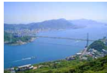
関門橋【下関市】
